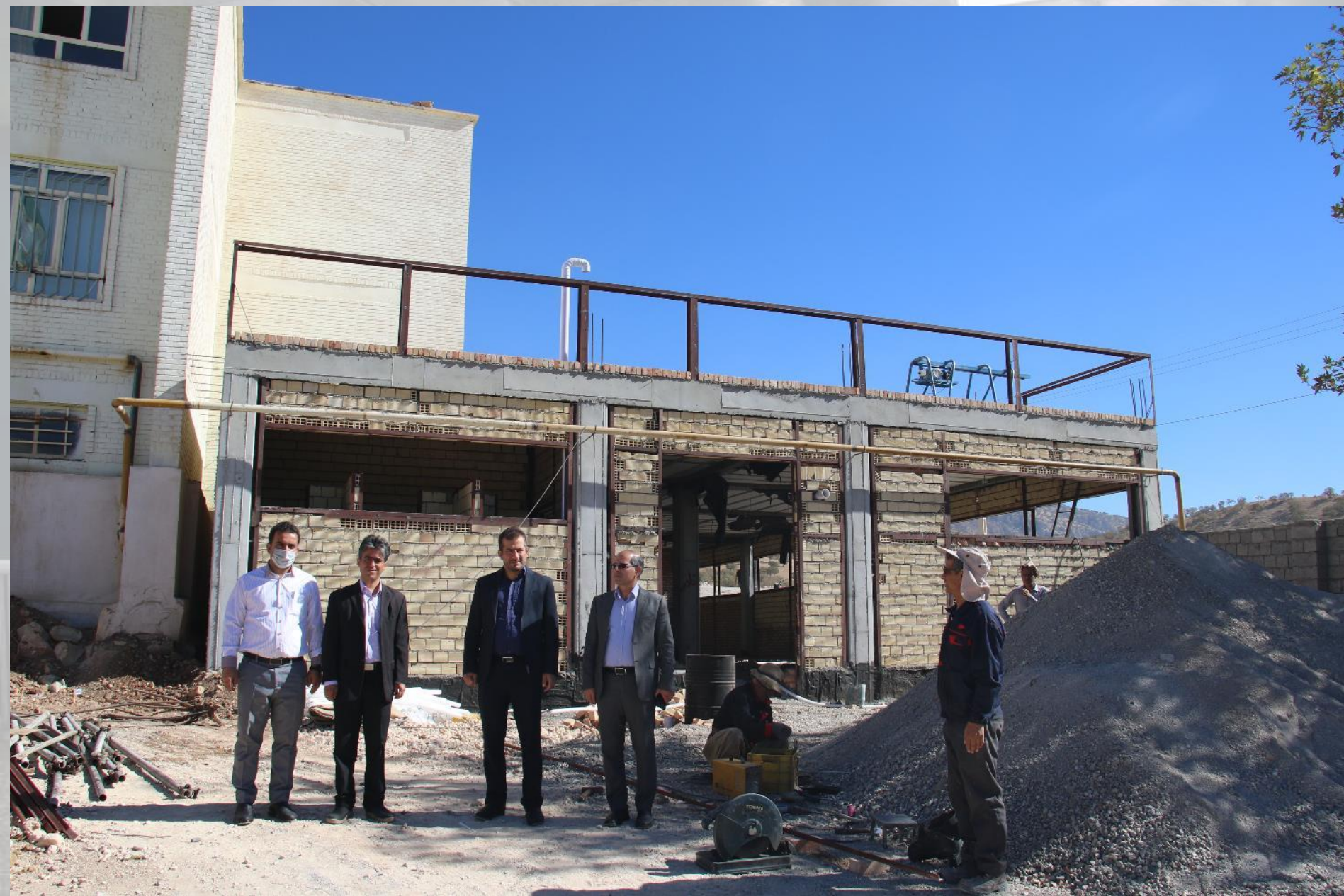
احداث سالن بدن سازی در پردیس خوابگاهی برادران
