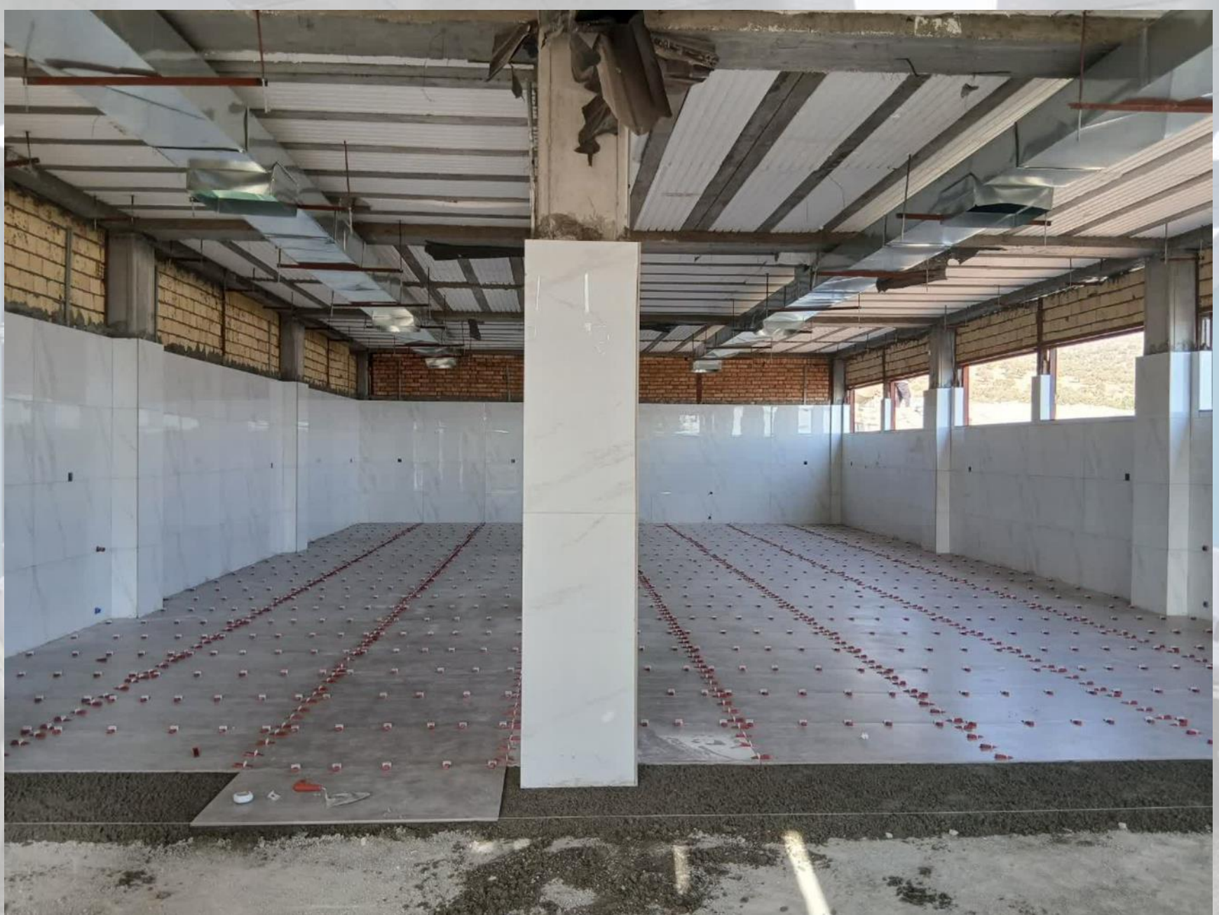
احداث سالن بدن سازی در پردیس خوابگاهی برادران
